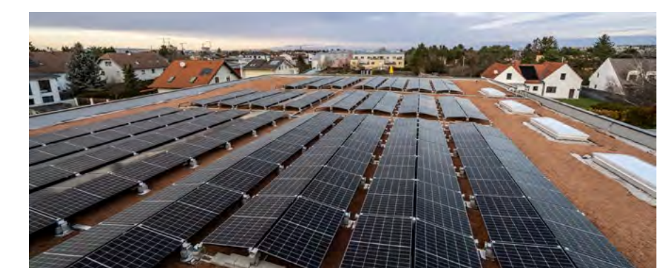
Photovoltaikanlage auf dem Dach des BILLA Marktes in der Pilotengasse.
